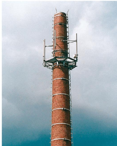
Realisierung einer Basisstation an einem Industrieschornstein
